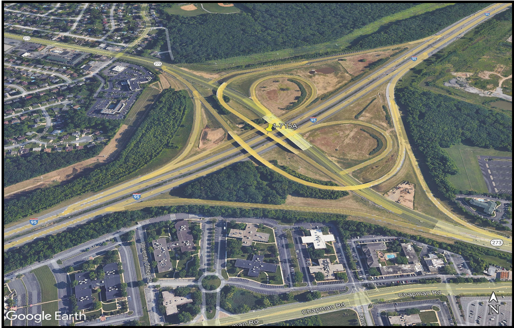
BR 1-715A (Ramp 6048 over I-95)
